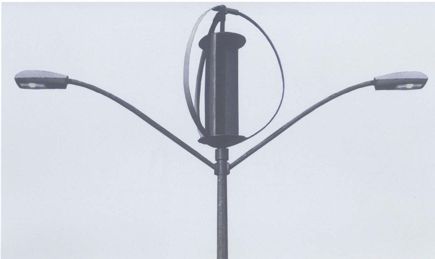
Modello d'impianto per l'illuminazione pubblica con alimentazione eolica
