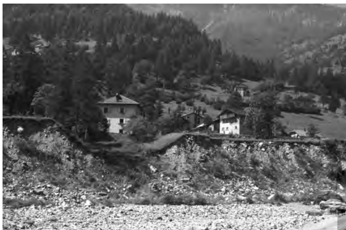
Figura I.6. Deposito fluviale e paleoalveo “terrazzati” e sospesi sul letto del torrente Cordevole (Belluno). Fonte: foto di M. Panizza, luglio 1973.
