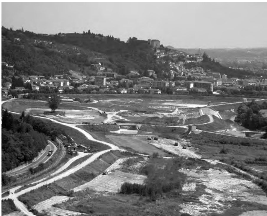
Figura 9.2. Un esempio di intervento per la mitigazione del rischio idraulico: la cassa di espansione sul fiume BelBo.
