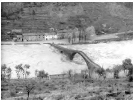
Figura 10.6. Vista dall'alto del Ponte del Diavolo presso Borgo a Mozzano (Lucca) durante l'evento di piena del novembre 1982.
