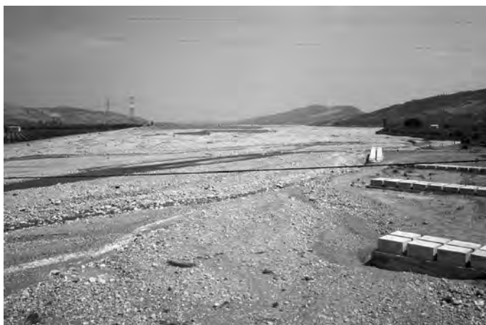
Figura 1.4. Valle della Fiumara Trionto, in Calabria, verso la foce. Sulla sponda destra, i pennelli a difesa dell'erosione laterale.
