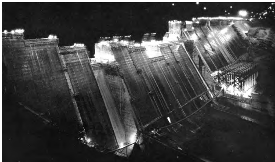
Figura 6.4. Veduta notturna della diga Norris in costruzione. Fonte: S. Chase, Rich Land, Poor Land , 1936, di fronte, p. 164 (foto di Charles Krutch).
