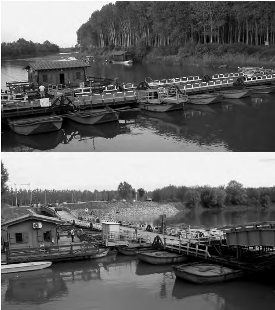
Figura 17.4. Il Ponte di Torre d'Oglio: sopra, il ponte fino al 2008; sotto, il ponte oggi dopo il restauro. Fonte: http://www.panoramio.com/photo/
