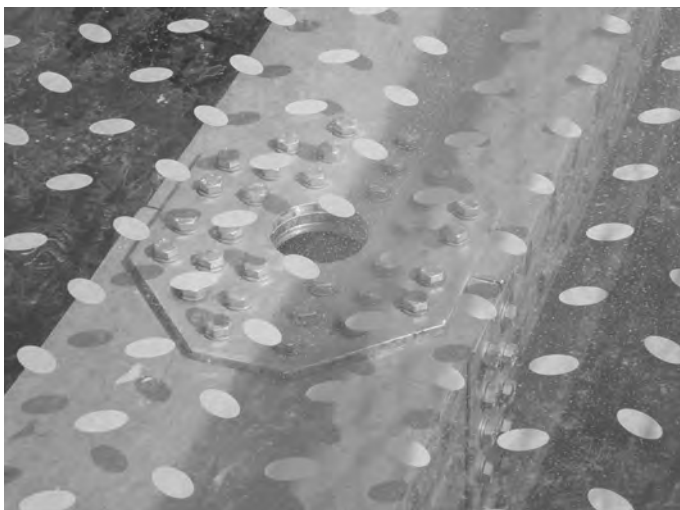
Figura 16.17. Hashi , Roma, passerella pedonale sulla Cascata del lago dell'Eur (particolare). Fonte: foto di Paola Ghirotti.
