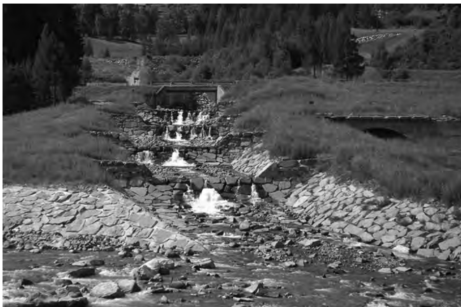
Figura I.8. Serie di briglie lungo un affluente del torrente Avisio (Val di Fiemme, Trento).
