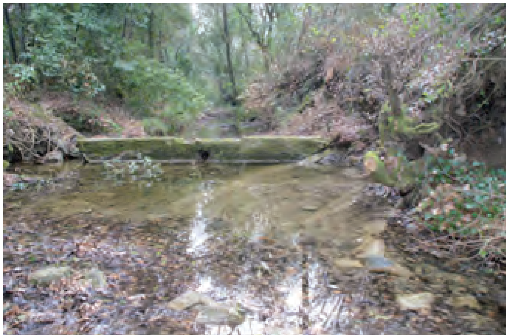
Foto 47. Rio Popogna, gradone a dislivello. Località Fonte all'Amore. Marzo 2012. Foto Paolo Pasquinelli.
