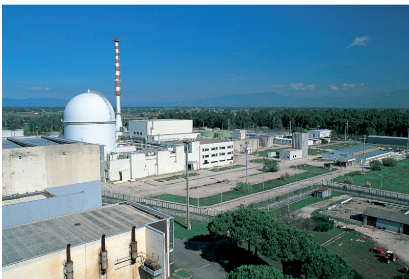
Fig. 1 - La centrale nucleare di Latina (per gentile concessione di Sogin Spa).
